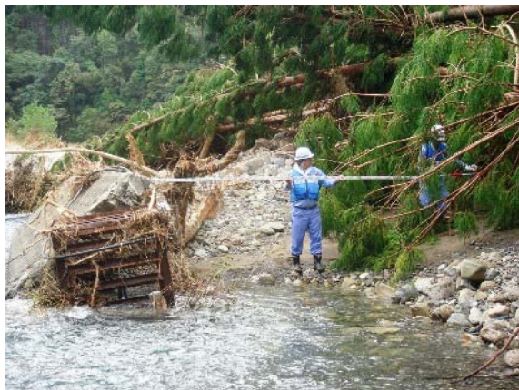
護岸崩壊の被災調査【赤木川】 （新宮市熊野川町上長井地区）
