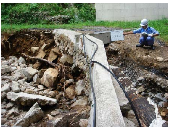
護岸崩壊の被災調査【佐野川】 （新宮市三輪崎地区）
