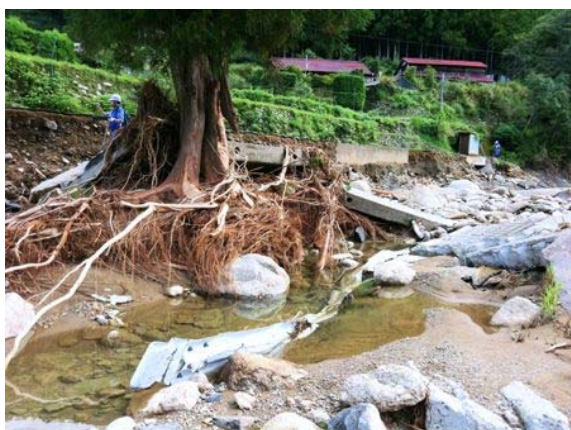
護岸崩壊の被災調査【里高田川】 （新宮市高田地区）
