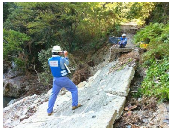
坂路崩壊の被災調査【和田川】 （新宮市熊野川町鎌塚地区）
