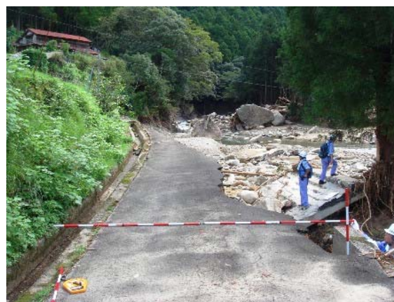
護岸崩壊の被災調査【里高田川】 （新宮市高田地区）
