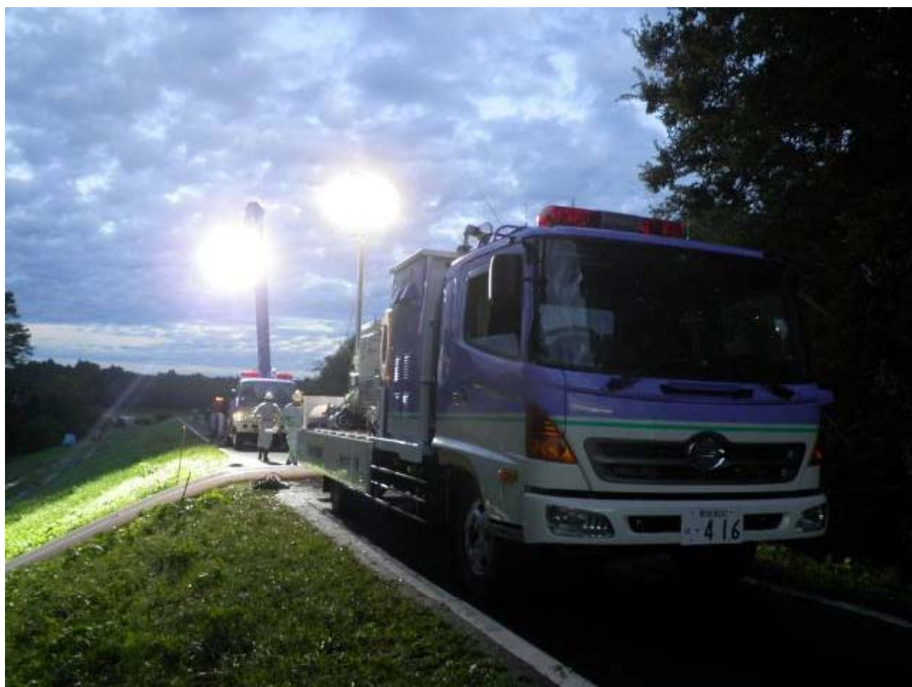
排水ポンプ車及び照明車
