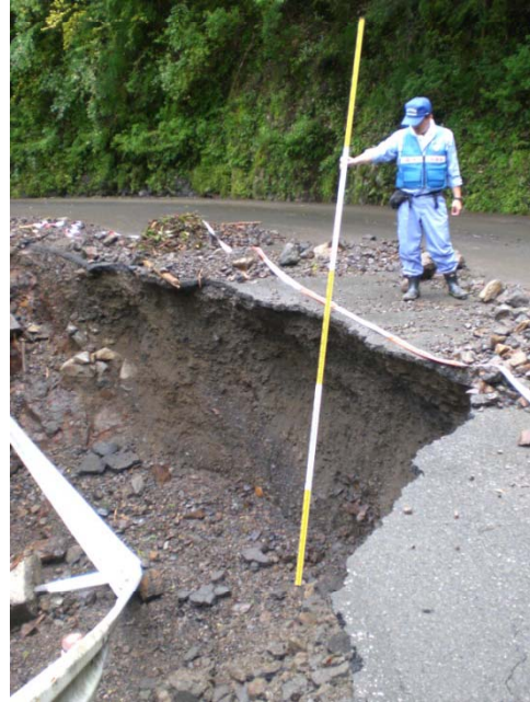
④路肩崩落 タマカワ 玉置川地区
