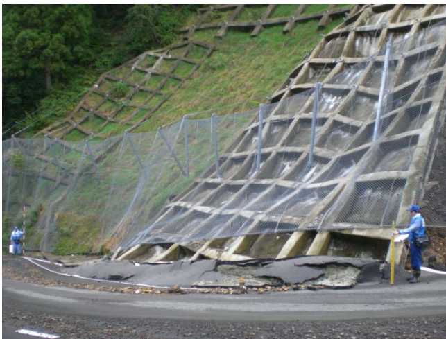
⑤法面崩落 ヤマタニ 山手谷地区
