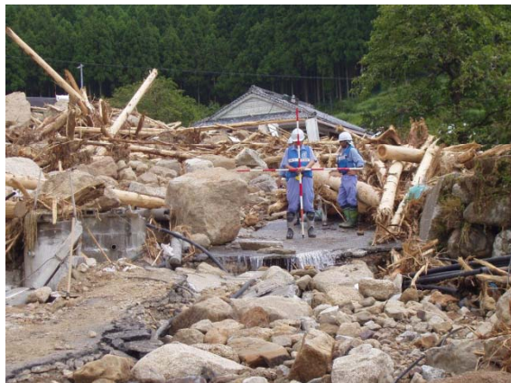
土石流の被災調査【太田川】 (那智勝浦町口色川地区)
