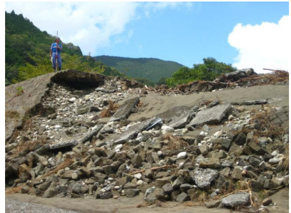
堤防の被災調査【古座川】
