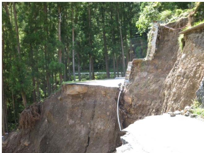
①道路崩壊 谷垣内地区
