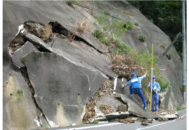
⑥法面崩落 オハラ 小原地区
