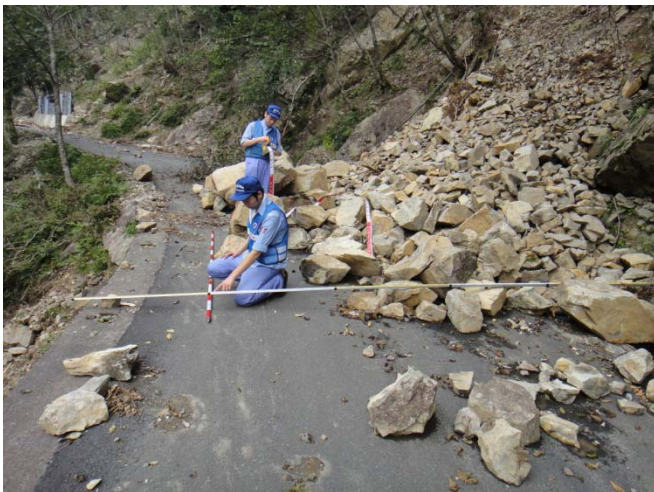
⑦落石 カミユカ 上湯川地区
