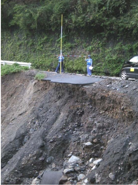
③路肩崩落 タカハギ 高滝地区
