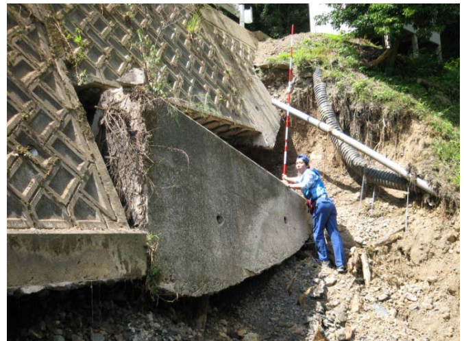
⑧擁壁倒壊 ヤマテ 山手地区
