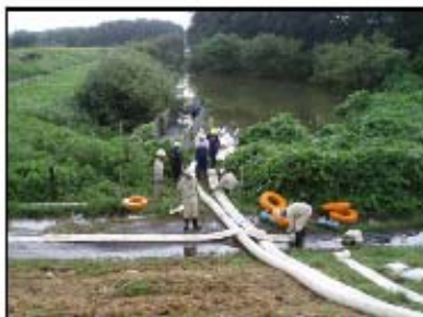
排水ポンプ設置作業状況(9/1 17時頃)
