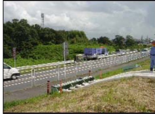
排水ポンプ車設置状況
