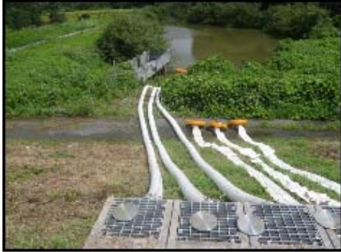
取水箇所及び排水ポンプ・ホース設置状況
