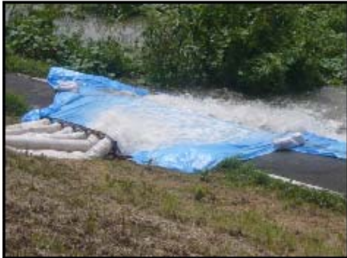
排水吐出状況①
