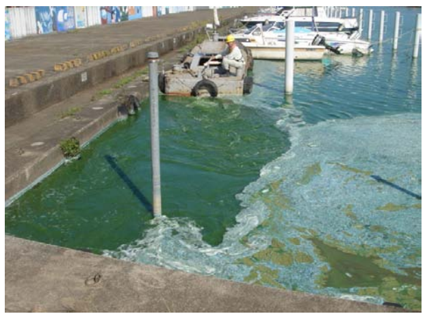
腐敗アオコの攪拌: 悪臭を断つための応急策
