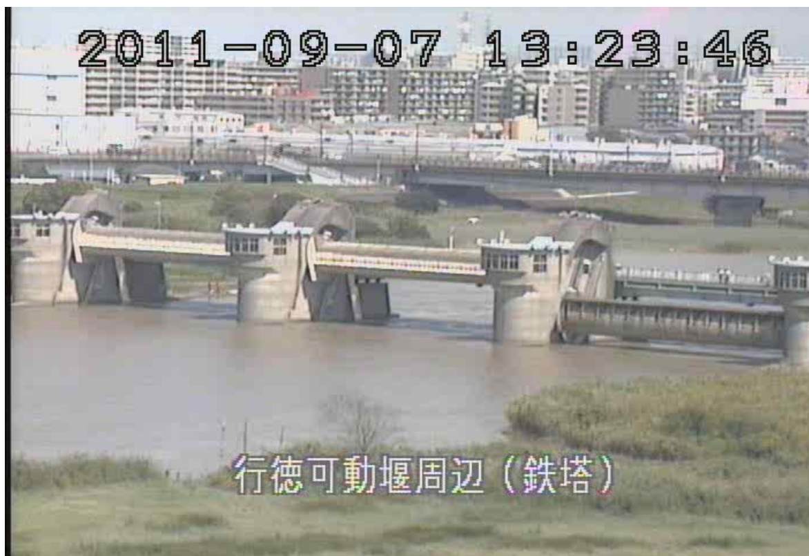
行徳可動堰 閉門操作開始（右岸側ゲート閉操作中）
