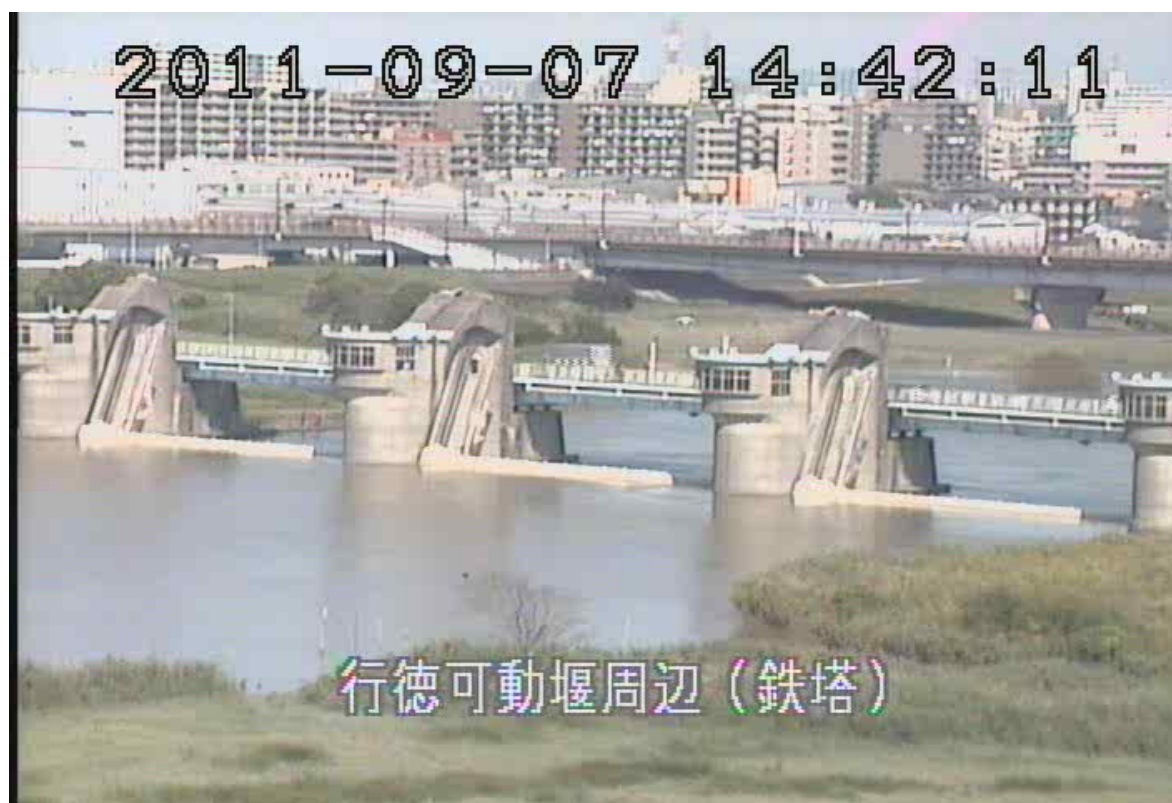
行徳可動堰 閉門操作完了
