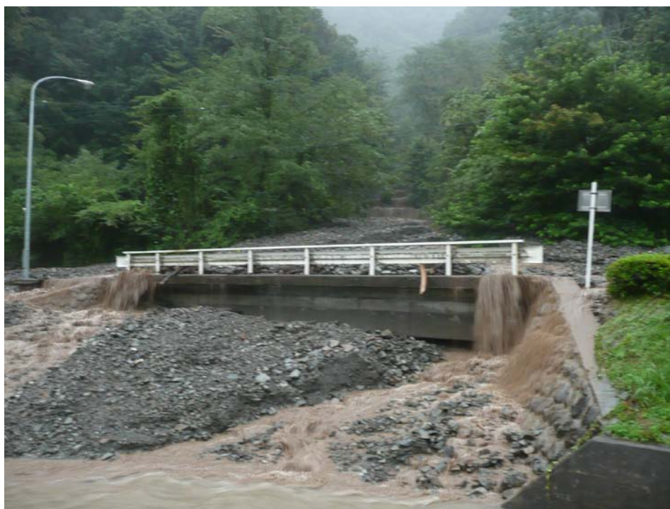
早川町保地区 唐沢堰堤付近の県道被災状況（9月4日6時頃）
