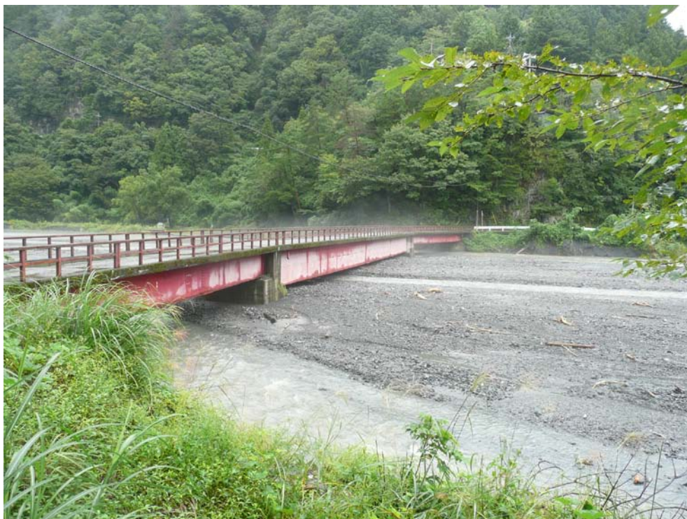
早川町雨畑地区の県道（奥沢橋）の土砂堆積状況（9月5日11時頃）
