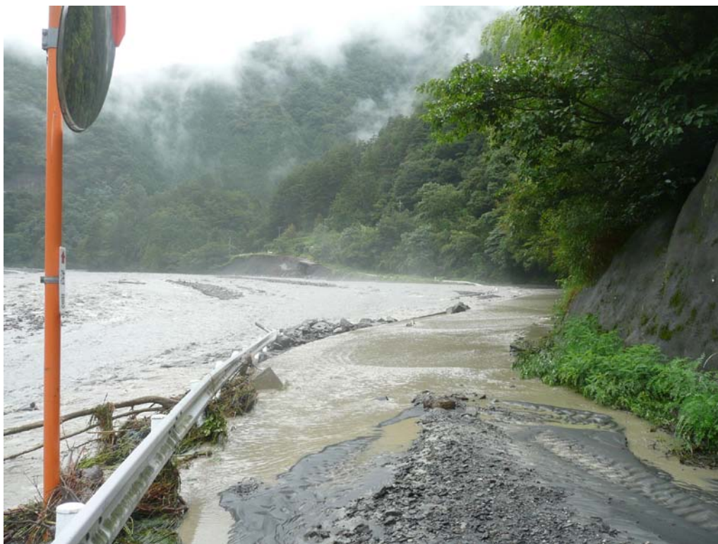
早川町雨畑地区の町道の被災状況（9月5日11時頃）
