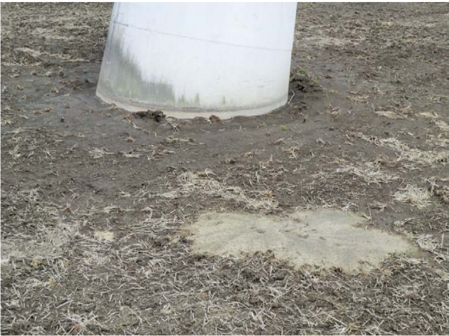
高圧送電鉄塔基礎には影響なし
