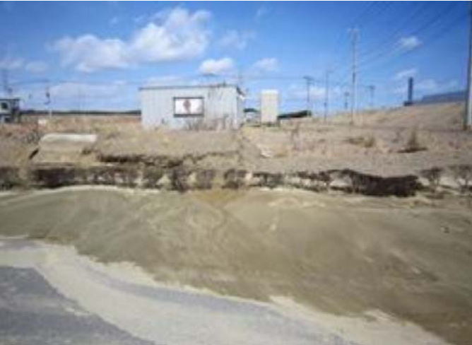
基礎地盤コンサルタンツ(株) 2011/3/17
