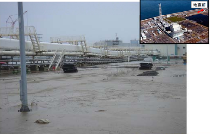
-送炭コンベア(常陸那珂火力発電所)-
