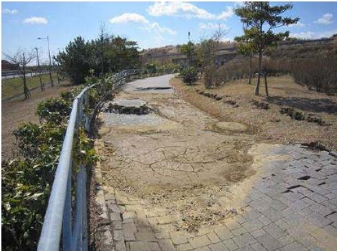
茨城大学調査報告（その3）2011/3/18 常陸那珂港
