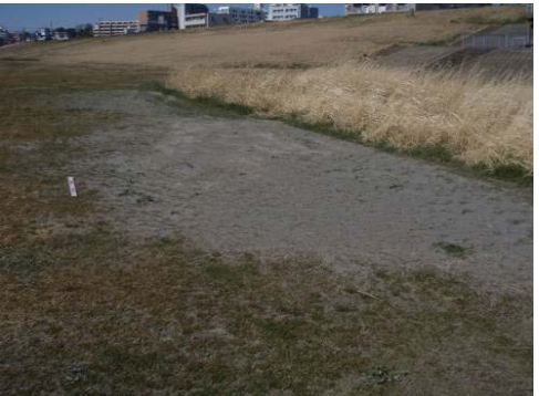
利根川下流河川事務所 利根川左岸84～85km付近
