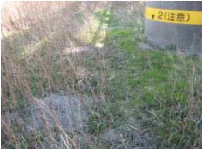
左岸JR鹿島線橋台下
