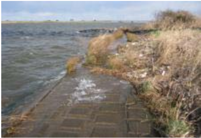
利根川下流河川事務所 右岸JR鹿島線橋台下
