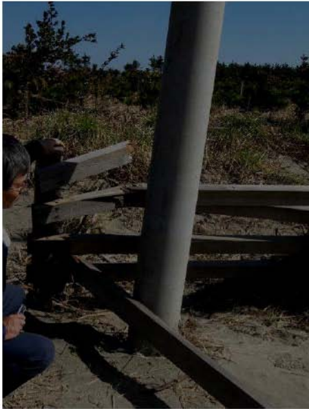
山武市小松：電柱は傾きながらの沈み込んだ後、津波の浸水があり、水面跡は水平についている。
