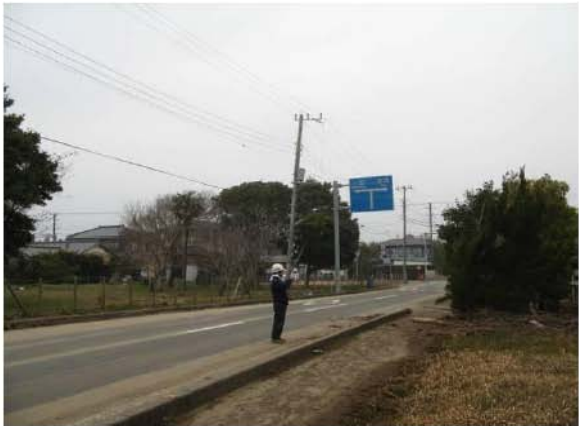
山武市蓮沼平：電柱と案内板の支柱は傾きながら沈み込んだ。
