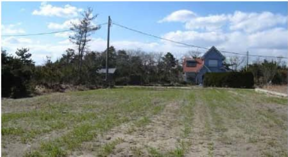
山武市小松：電柱の傾きながらの沈み込み
