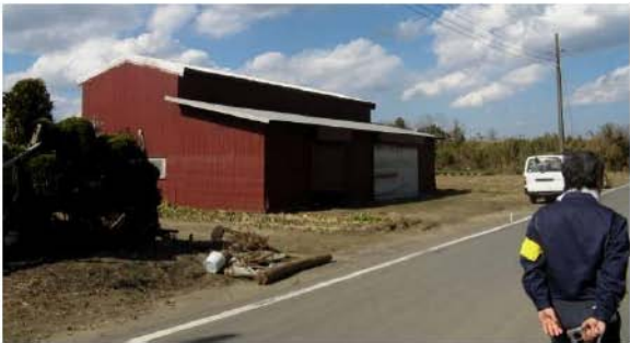
山武市小松：津波により地表から1.8mまで浸水した。建物の窓の高さくらいに津波水面の模様が残る。
