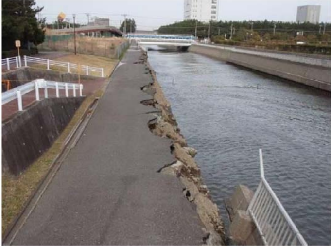
千葉県環境研究センター（東北地方太平洋沖地震による東京湾岸埋立地での液状化－流動化被害）
