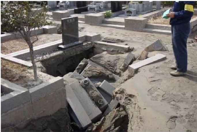
千葉県環境研究センター（東北地方太平洋沖地震による東京湾岸埋立地での液状化－流動化被害）
