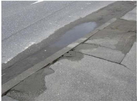
液状化の痕跡:穴から泥の混じった水が噴出した
