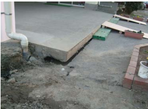
液状化の痕跡:穴から泥の混じった水が噴出した
