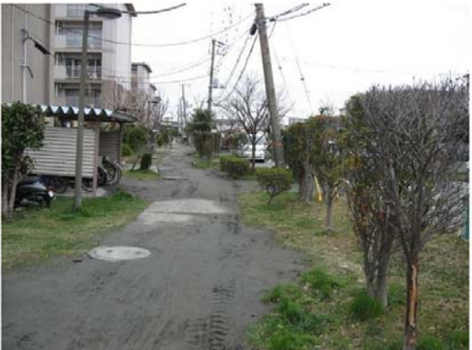
袖ヶ浦団地の敷地にて:液状化により、敷地一面が泥だらけに
