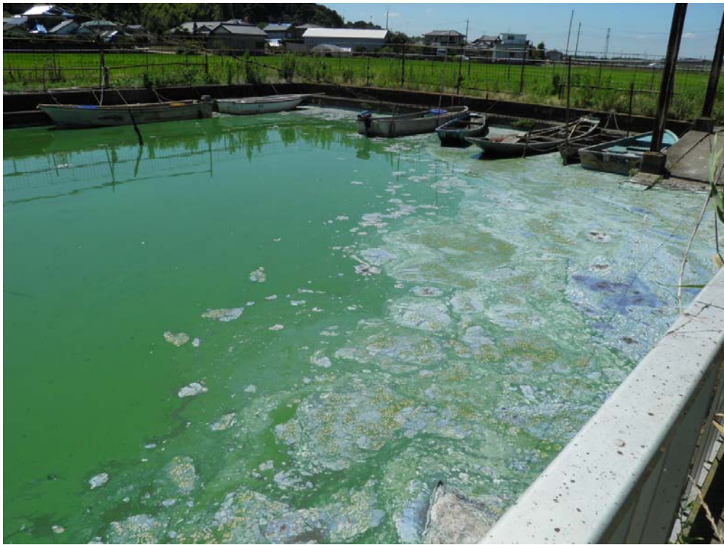
北浦右岸36. 0km+10m新河岸舟溜り内
