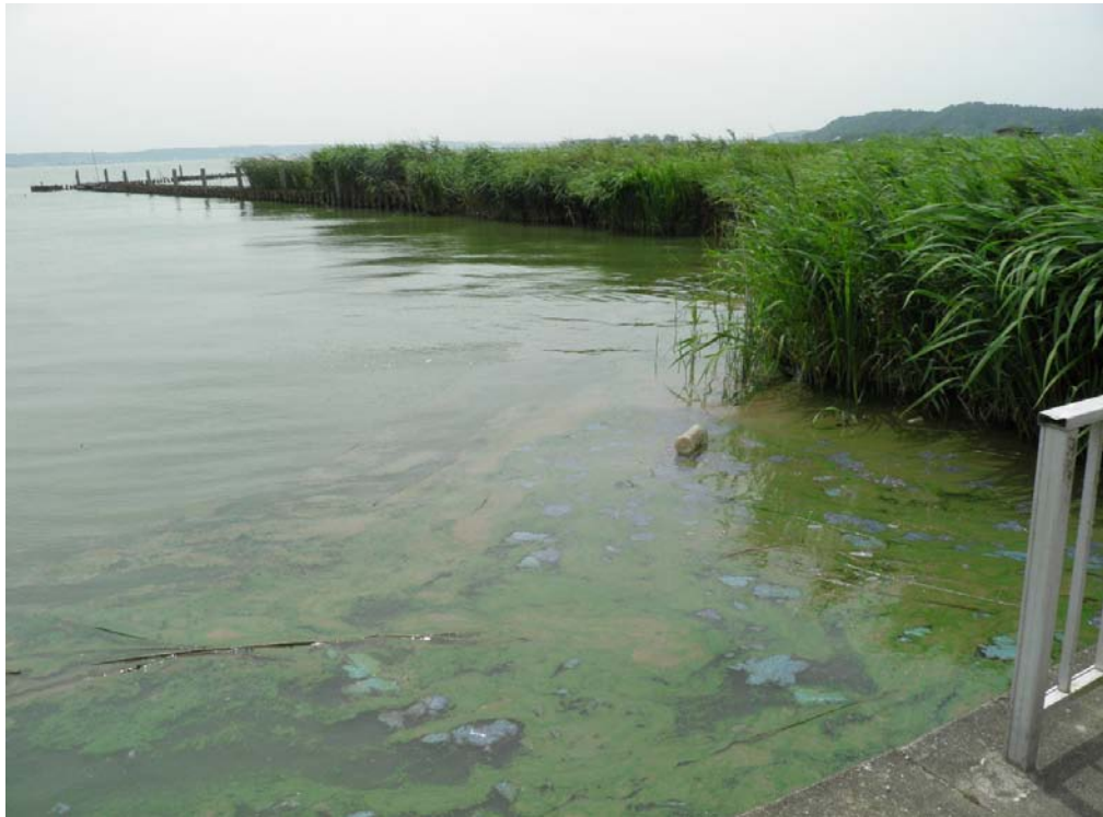
北浦右岸25. 0km+40m山田高位部排水樋門前面
