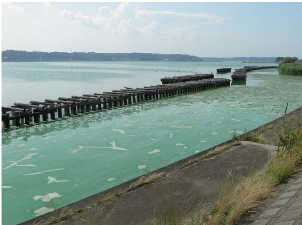
北浦左岸22. 0km+60m梶山消波施設内の状況
