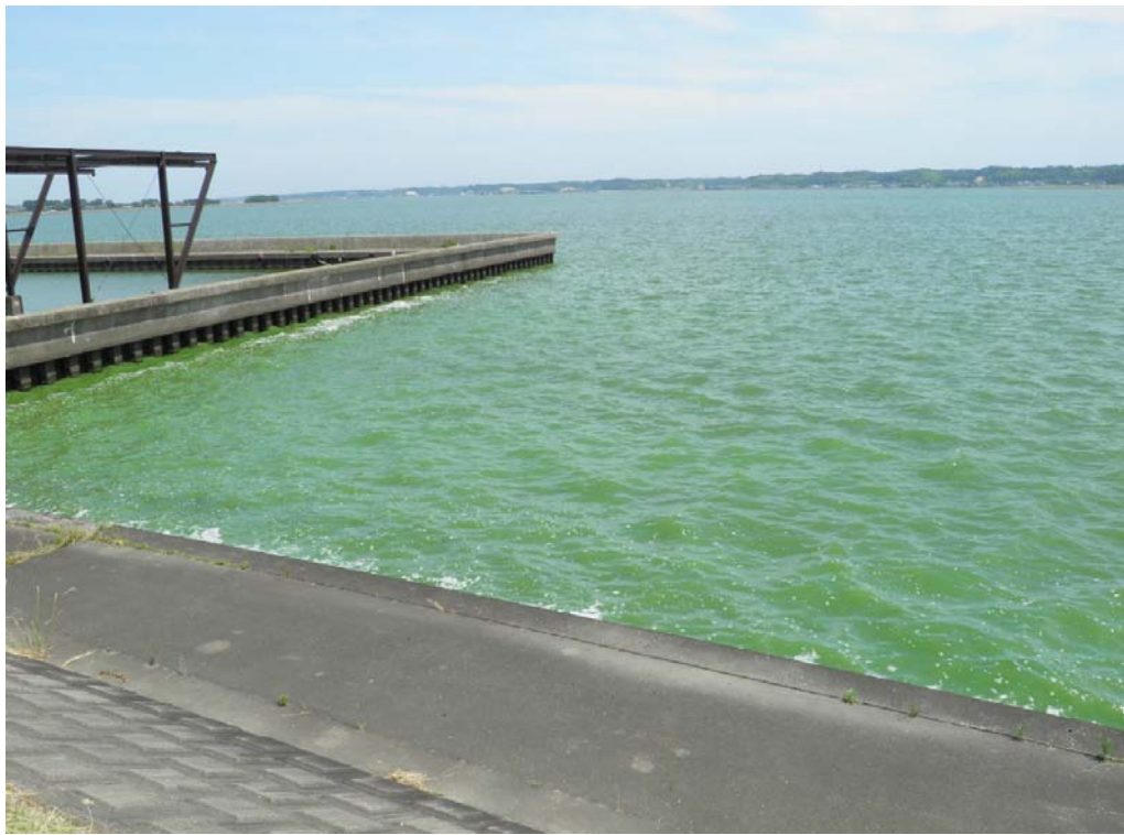
北浦右岸14.75km付近 行方市白浜地先
