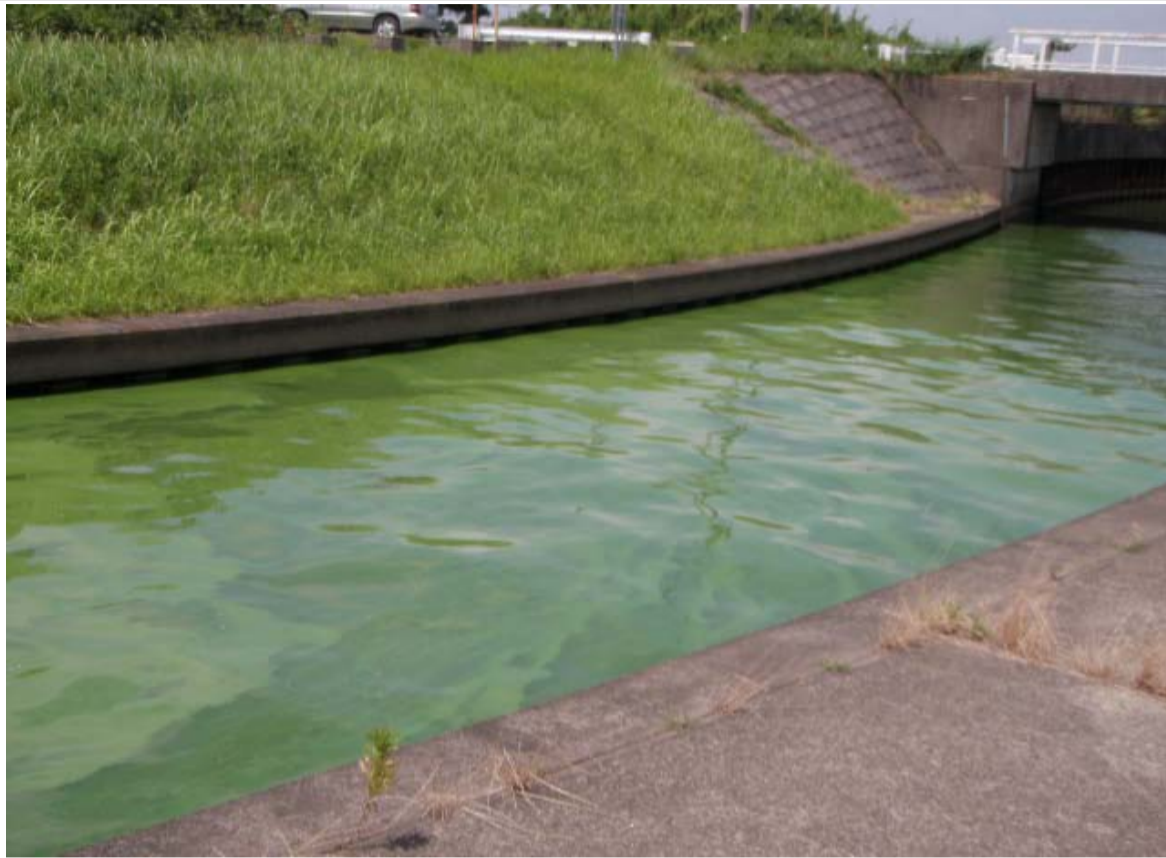
西浦右岸27.00km-70m(余郷入承水路)
