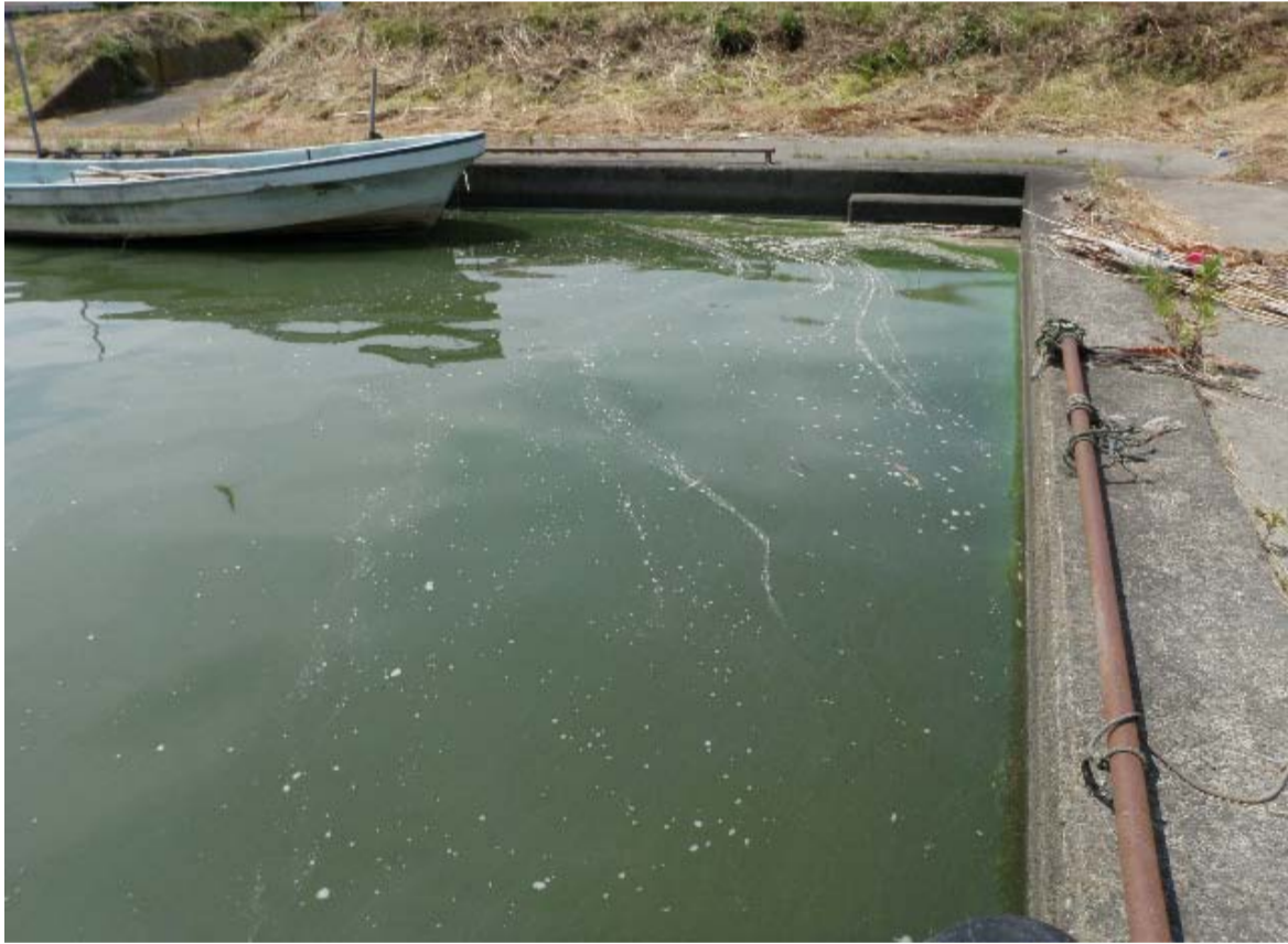
中岸29.25km+120m(小津舟溜り)
