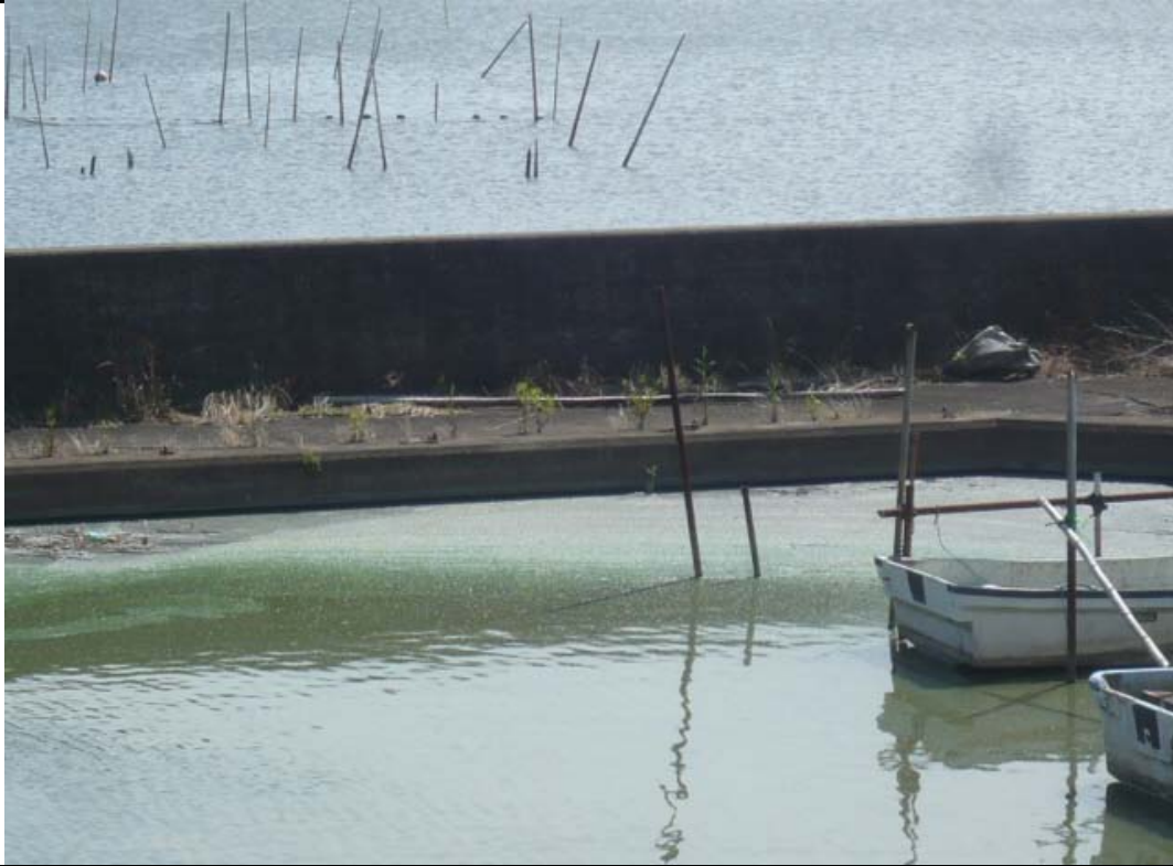
北浦左岸26.5km+20安塚舟溜内
