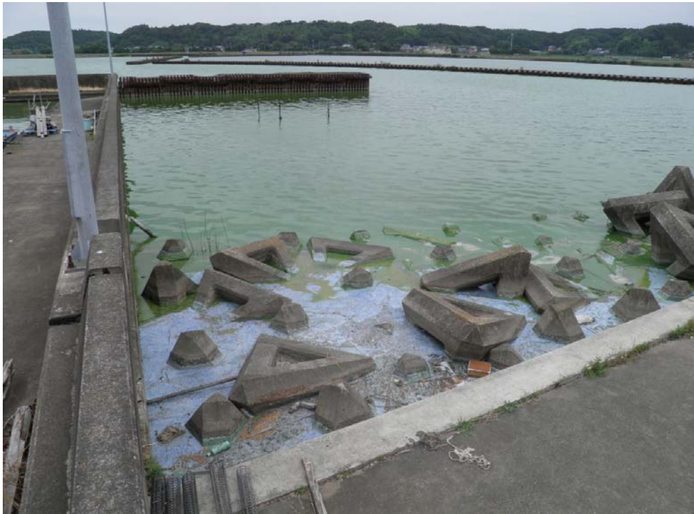
(北浦右岸21.5km+80m吉川舟溜付近)
