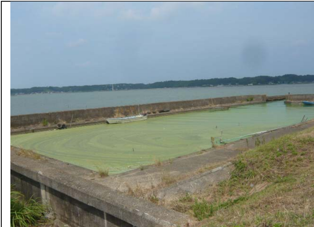
北浦右岸29. 25km—40鶴ヶ井舟溜内レベル5
