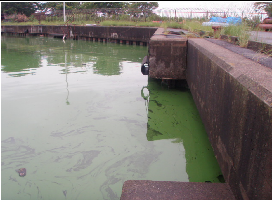
西浦右岸48.50km+70m(霞ボート)
