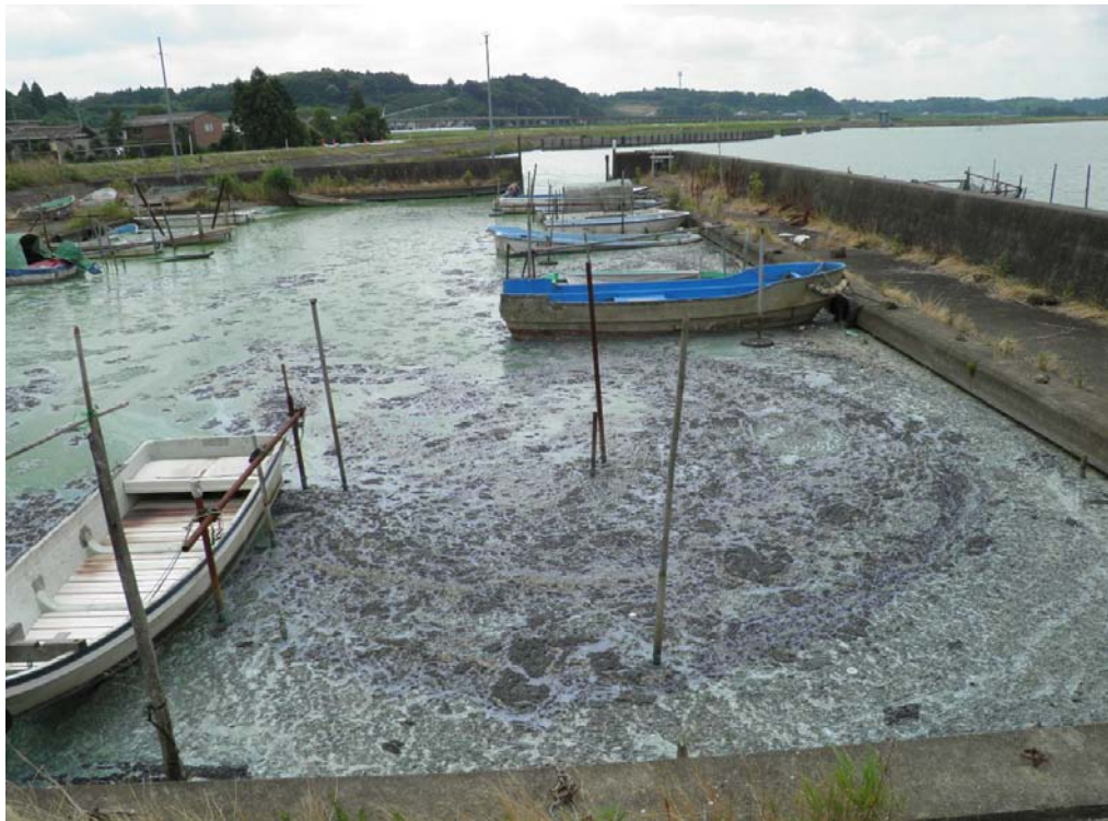
北浦左岸26. 5km+50m安塚舟溜まり内
