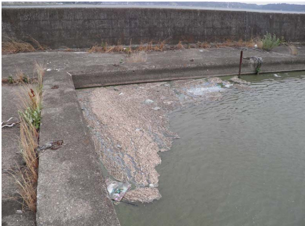
北浦右岸29. 25km-40m小舟津鶴ヶ居舟溜内
