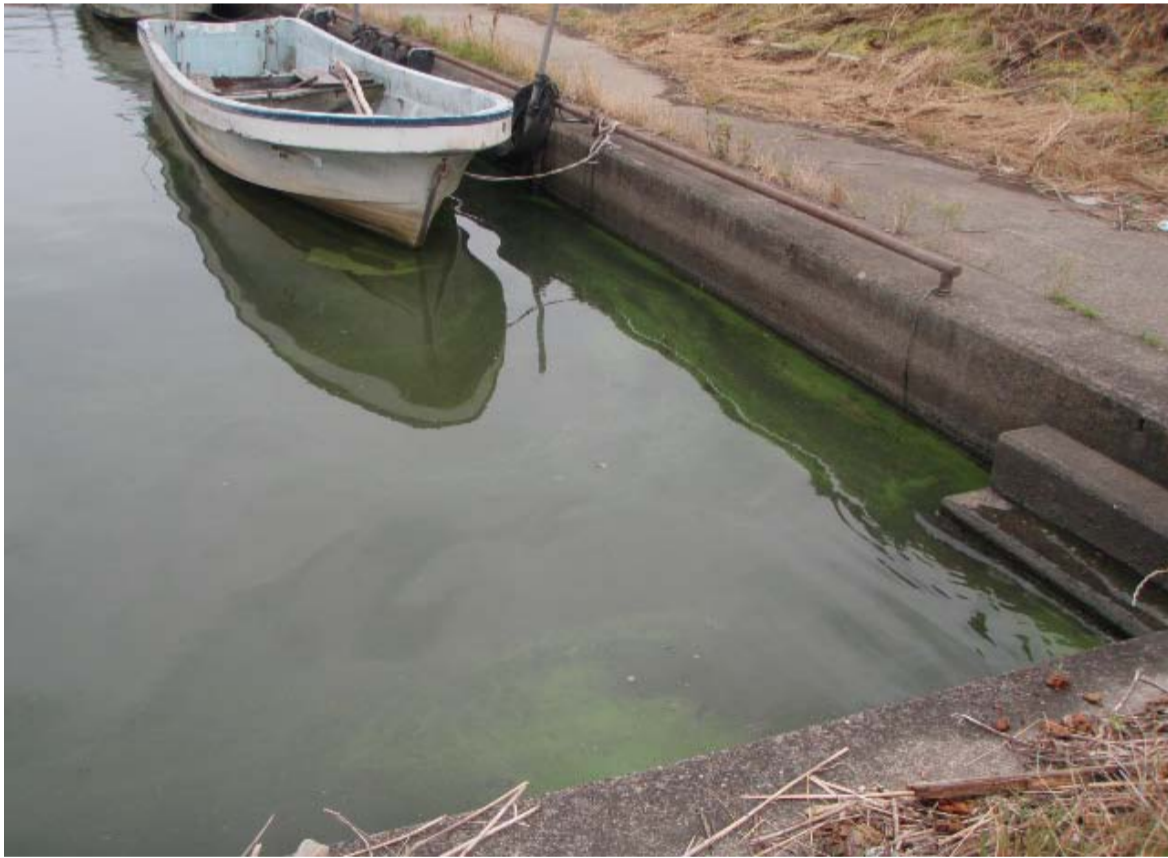
中岸29.25km+120m(小津舟溜り)
