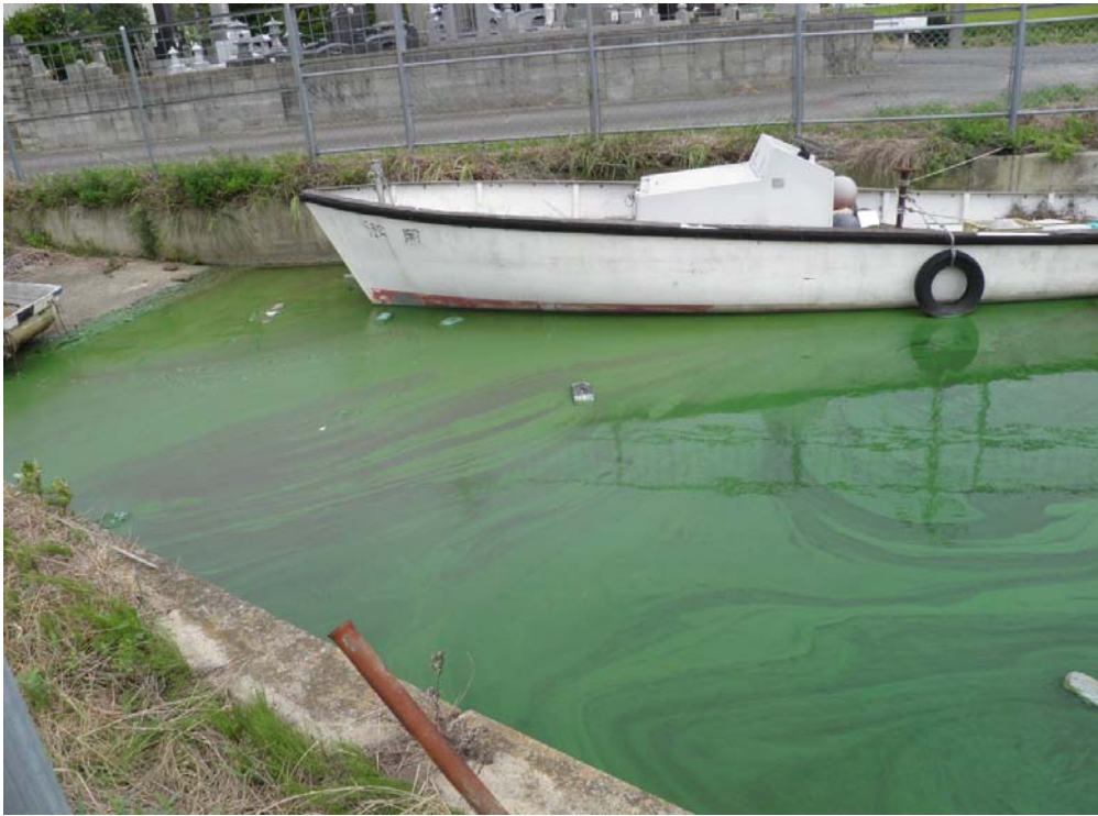
北浦左岸19.25km-50m江川第一舟溜まり内
