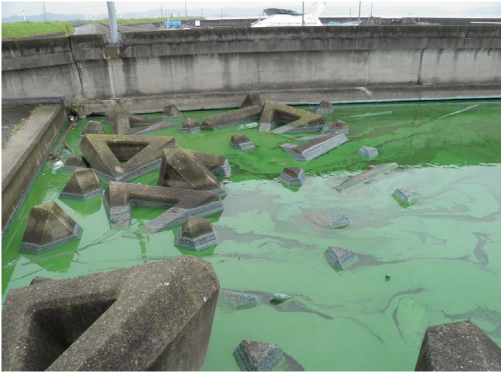
北浦右岸21.5km+50m吉川舟溜まり下流(レベル4、臭い有り)
