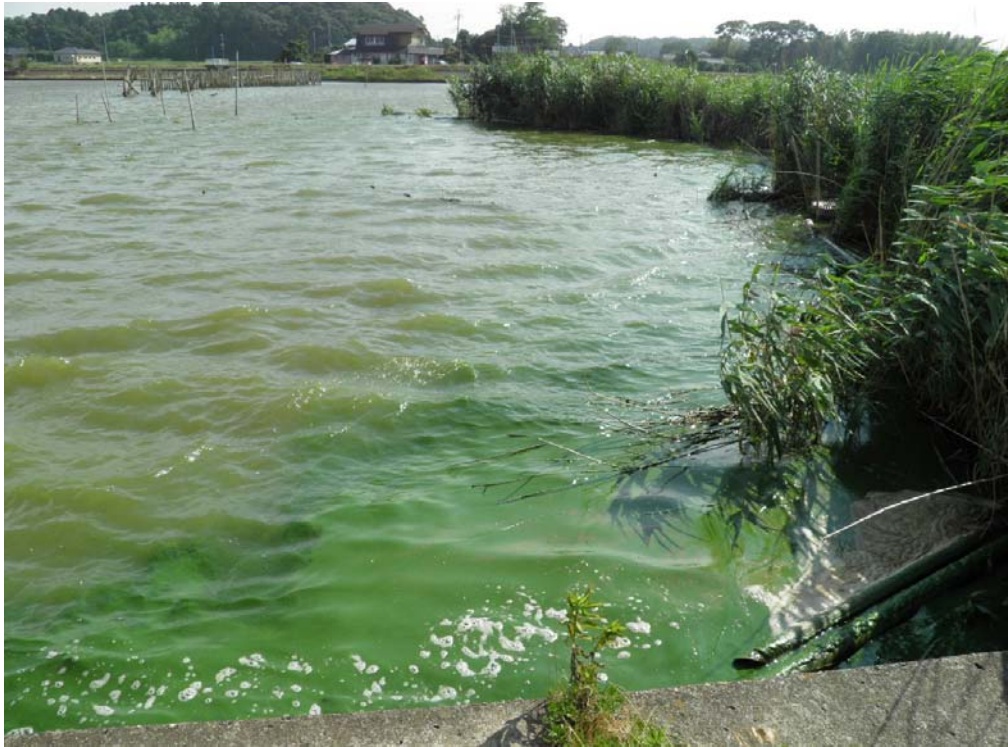
北浦右岸17. 25km+80m蔵川河口上流側
