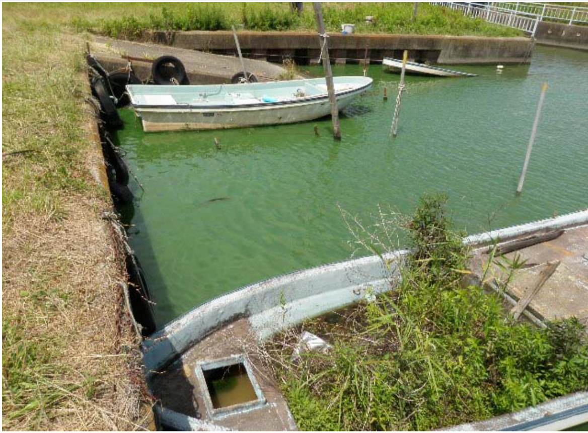
西浦中岸30.75km-80m(高賀津舟溜り)
