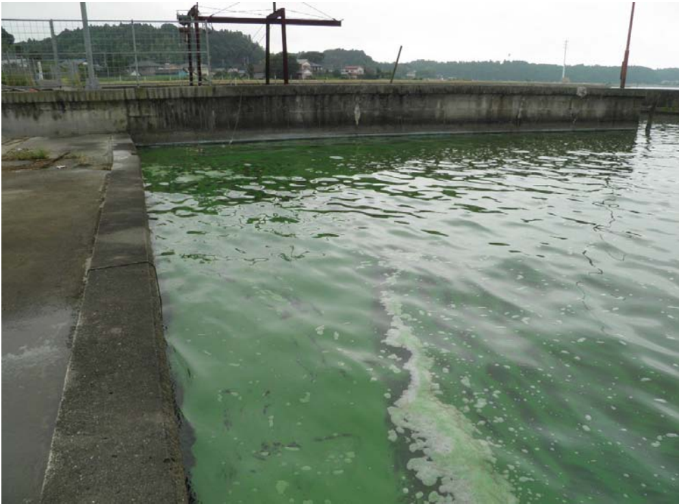
北浦左岸23.0km-100m付近
