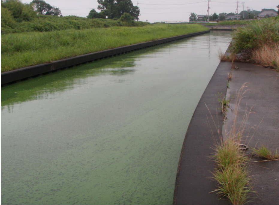
西浦右岸27.00km-50m(余郷入承水路)
