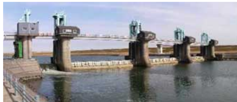
秋ヶ瀬取水堰（埼玉県志木市宗岡地先）
