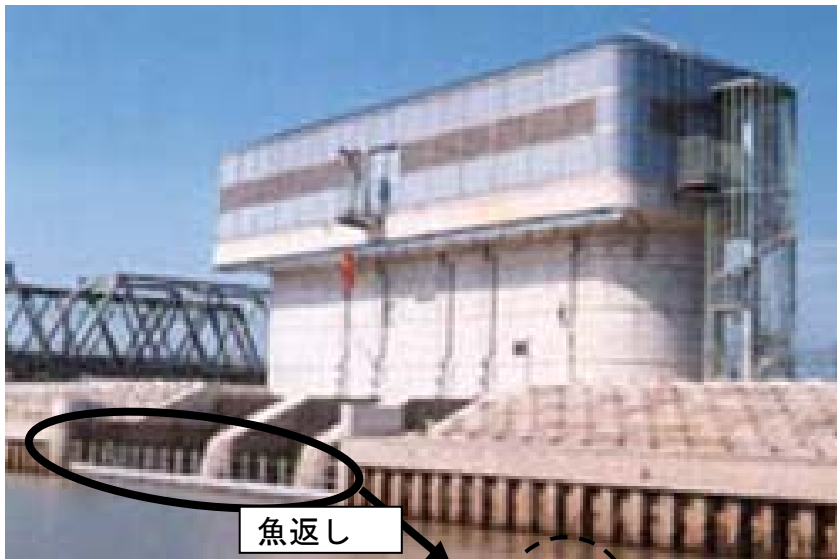
長良川導水(三重県桑名市長島町西外面地先)の例
