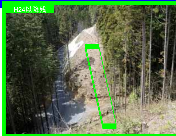
付替県道7号橋施工予定箇所(L=49m)
