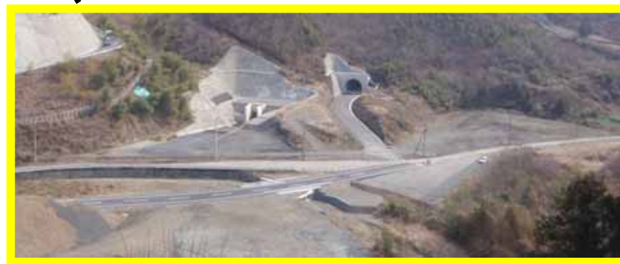
仮排水路・放流管敷設トンネル呑口(上流側坑口)(H23.3 竣工)
