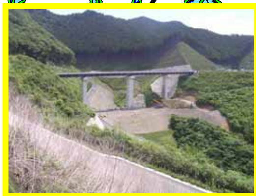
付替県道6号橋(H23.6.28)
