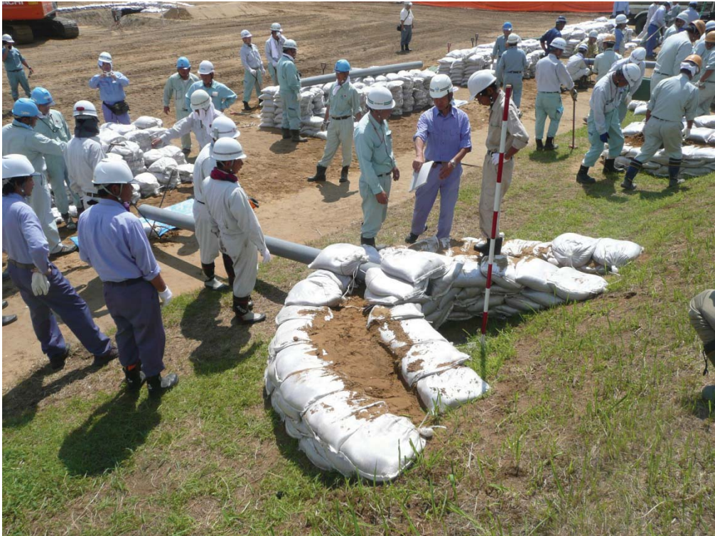
堤防裏法の漏水を想定しての月の輪工
