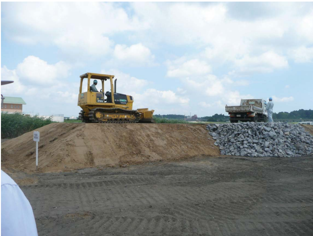
模擬堤防による割ぐり石まきだしの待避所等構築工
