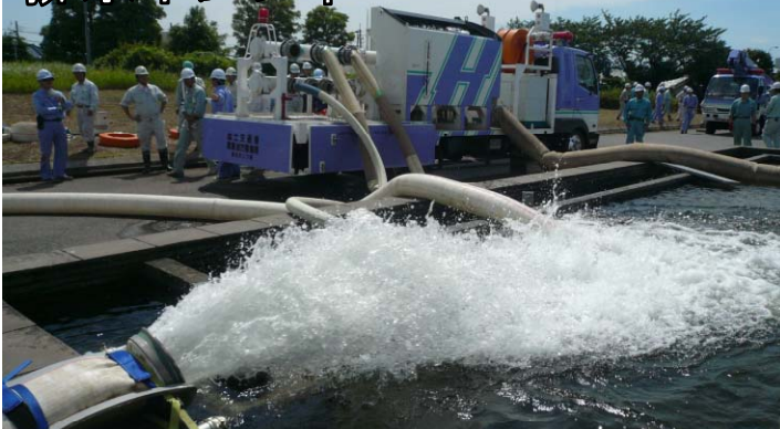
排水ポンプ車
