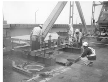
図3 床版ジャッキアップの様子
