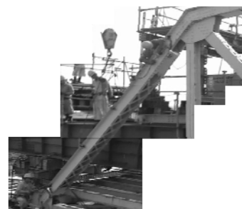
図5 トラス橋撤去（イメージ）
