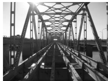
図4 床版撤去後の上部工
