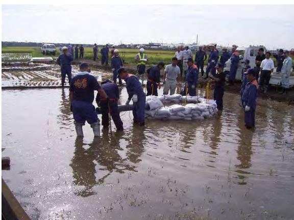
水防工法：釜段工法（利根川）H19.9
