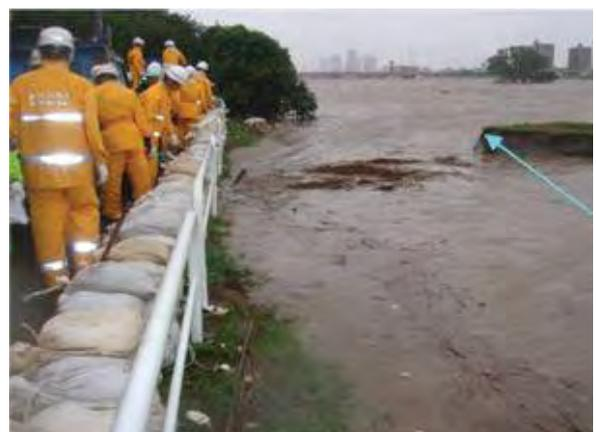
水防工法：土のう積み（多摩川）H19.9
