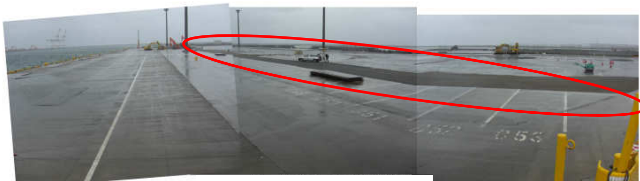
復旧後の状況
