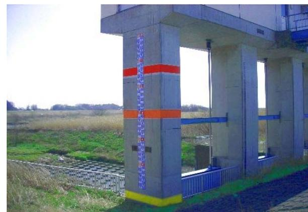
水門の門柱に設置した水位表示の例
