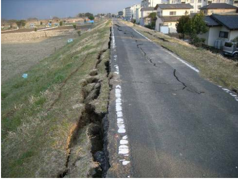
那珂川 [右岸 9.2k付近 水戸市若宮地先] 堤防沈下・亀裂による緊急対策【完了】
