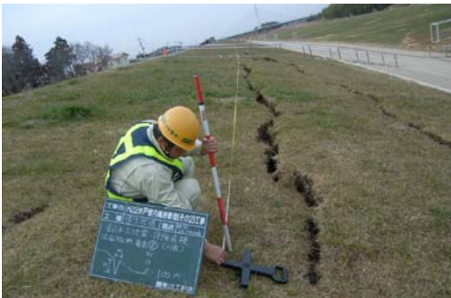
那珂川 [右岸 13.0k付近 水戸市根本町地先] 堤防亀裂による緊急対策【完了】
