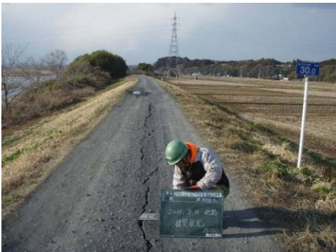
那珂川 [左岸 30.0k付近 常陸大宮市小場地先] 堤防沈下・亀裂による緊急対策【完了】
