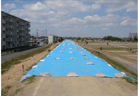
那珂川 [右岸 9.2k付近 水戸市若宮地先] 堤防沈下・亀裂による緊急対策【完了】
