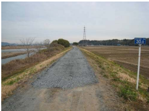
那珂川 [左岸 30.0k付近 常陸大宮市小場地先] 堤防沈下・亀裂による緊急対策【完了】
