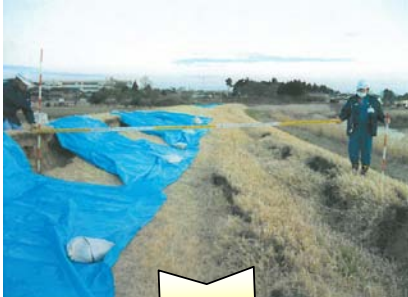
48 茨城県常陸太田市久米町地先 久慈川 山田川(左岸6.5k~6.9k)
