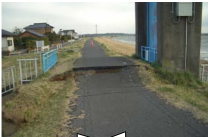
23 茨城県神栖市息栖地先 常陸利根川 常陸川（左岸10.7k）
