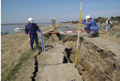
20 茨城県神栖市横瀬地先 常陸利根川 常陸川（左岸1.0k～1.5k）
