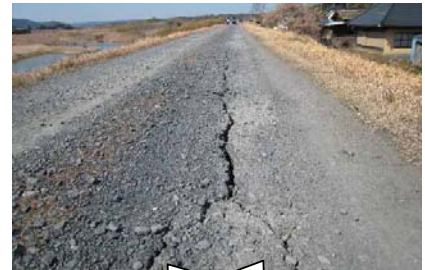
37 茨城県常陸大宮市小場地先 那珂川（左岸30.0k～31.0k）
