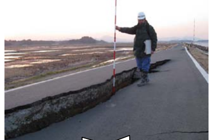
28 茨城県石岡市井関地先 常陸利根川 西浦(中岸33.1k~34.0k)
