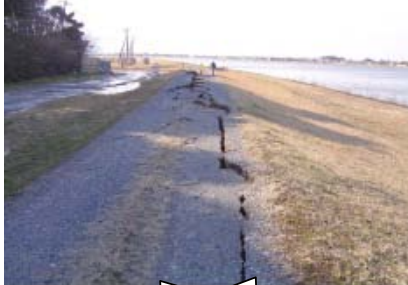
21 茨城県神栖市日川地先 常陸利根川 常陸川（右岸2.5k～5.0k）
