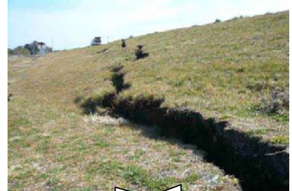
34 茨城県水戸市東大野地先 那珂川（右岸7.2k～7.3k）
