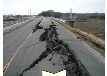
44 茨城県常陸太田市松栄町地先 久慈川(左岸18.3k~18.6k)
