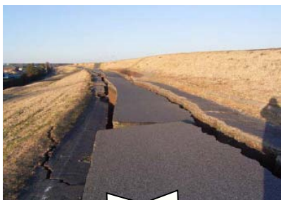
10 千葉県印旛郡栄町中谷地先 利根川下流(右岸69.7k~70.1k)
