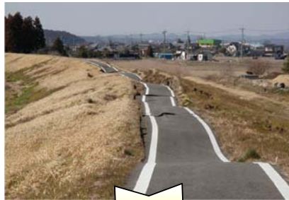
49 茨城県常陸太田市落合町地先 久慈川 里川(左岸-0.8k~-0.7k)
