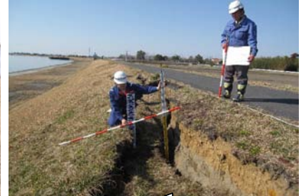
22 茨城県神栖市高浜地先 常陸利根川 常陸川（左岸8.0k～8.1k）
