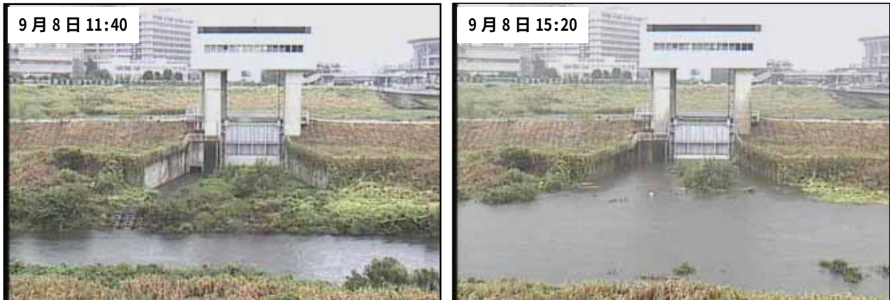
図2 鶴見川水系鶴見川 亀の子橋水位観測所（右岸 13.8k）
