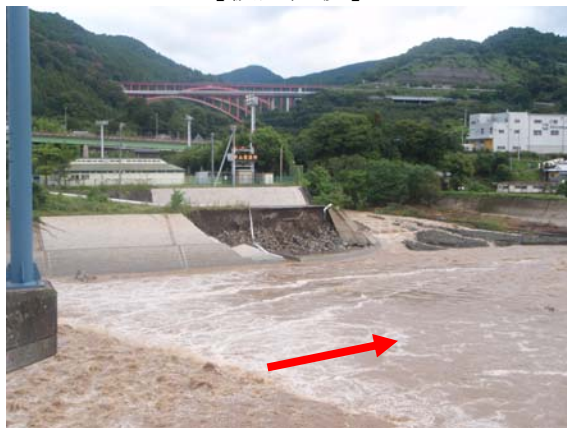
二級河川酒匂川 足柄橋下流付近
