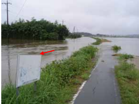
一級河川恋瀬川 出水状況 (石岡市根小屋地先)
