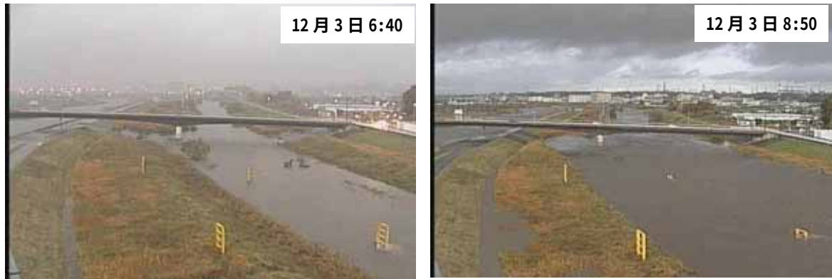
図3 鶴見川水系早淵川 高田橋水位観測所（右岸 1.43k）
