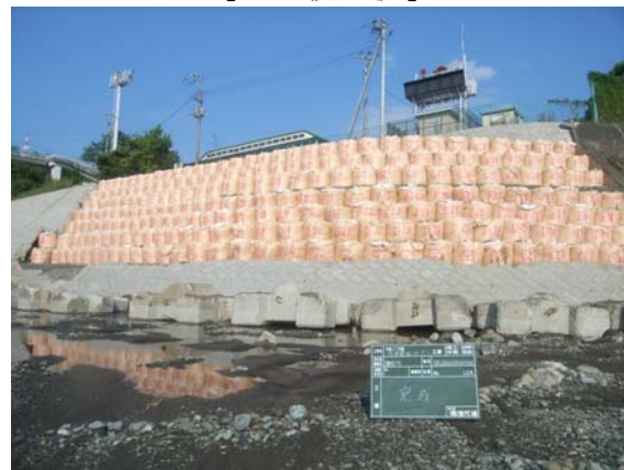
二級河川酒匂川 足柄橋下流付近
