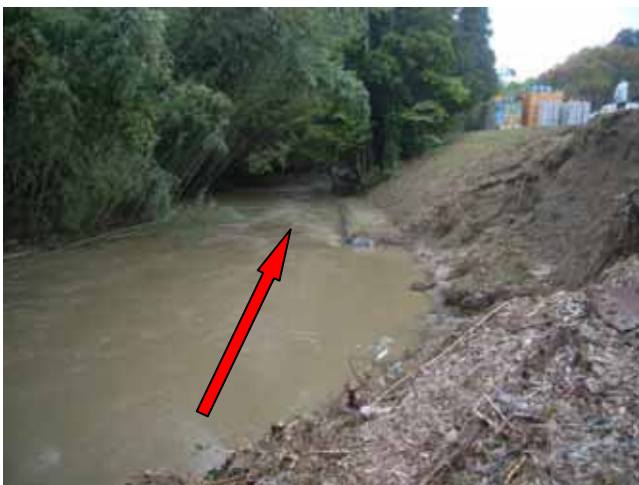
一宮川（長柄町鴛谷地先）右岸側の崩壊状況
