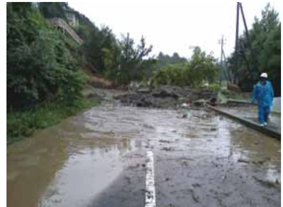
一般県道長岡大洗線 被害状況 (茨城県下石崎地内)
