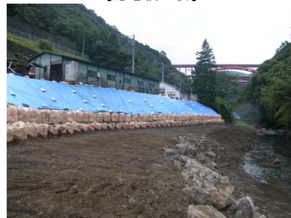
二級河川皆瀬川 (山北町山北地先)
