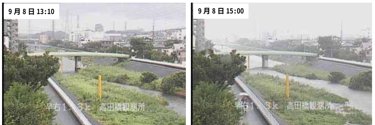
図4 鶴見川水系早淵川 高田橋水位観測所（右岸 1.43k）
