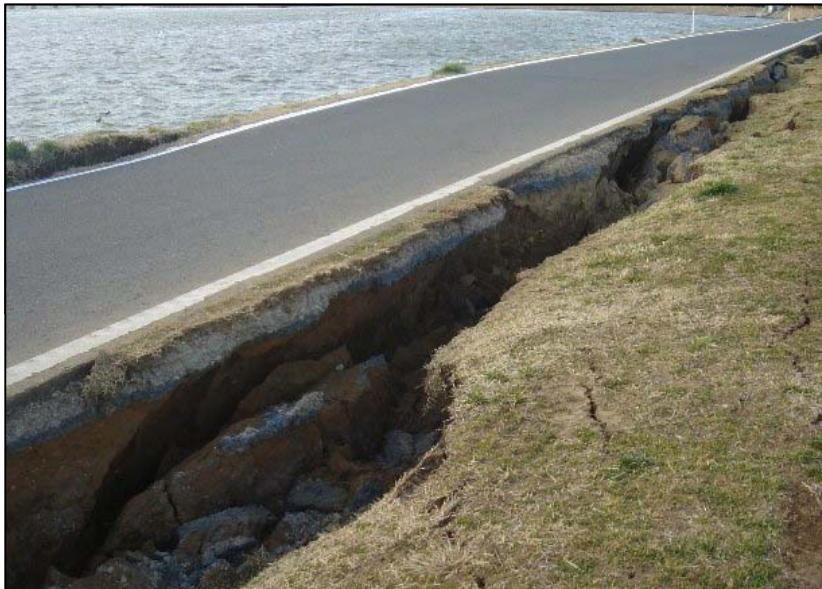
堤防上道路の破損状況
