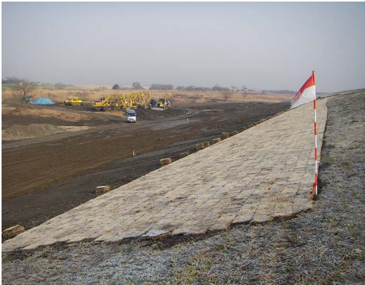
復旧状況 江戸川（左岸 58.2k~58.4k）平成 23 年 3 月 25 日 8 時現在
