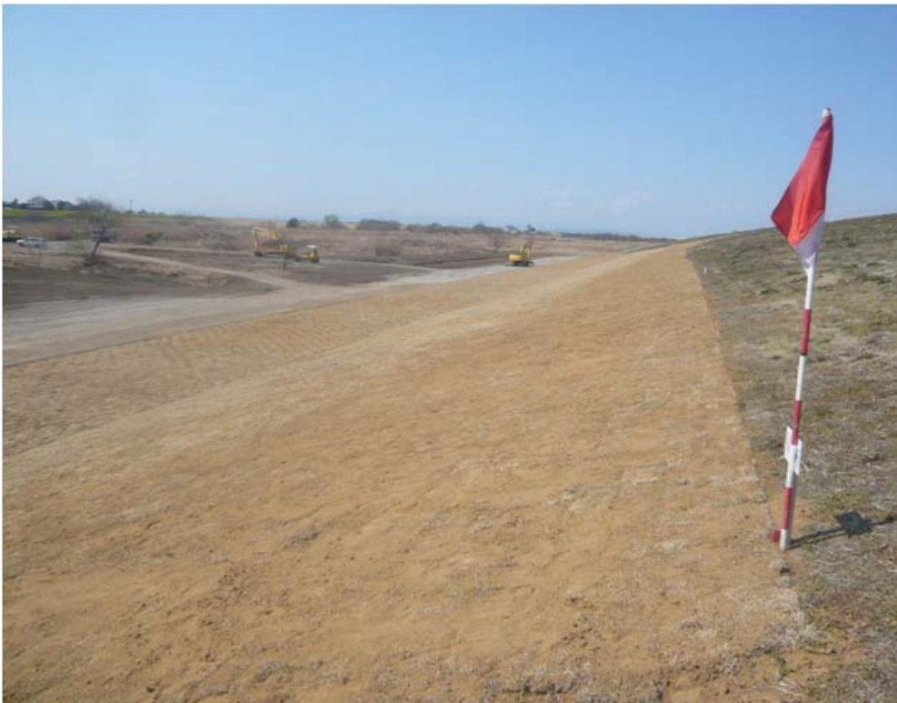
完了写真：H23. 3. 29 緊急復旧工事完了
