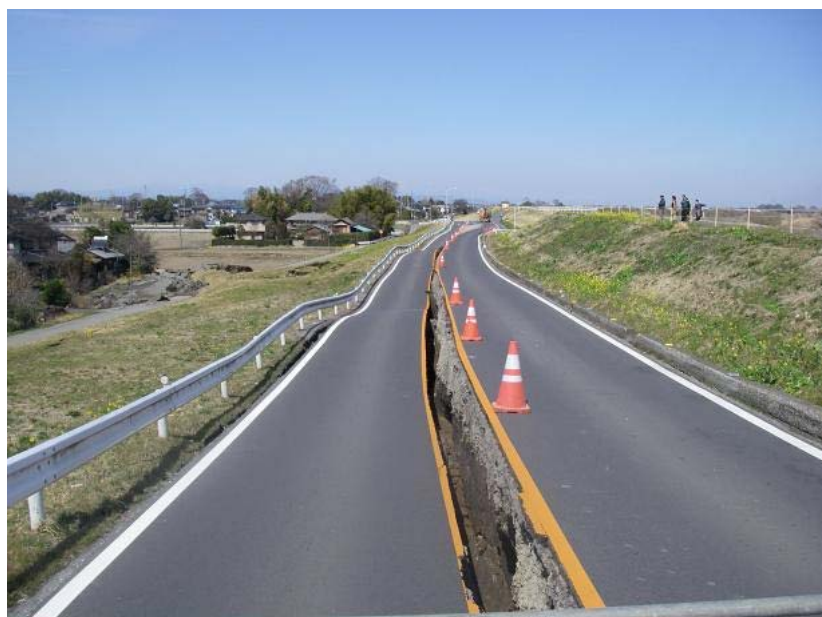
被災状況写真：被災状況 川裏（宅地側）堤防法崩れ 延長 L=200m
