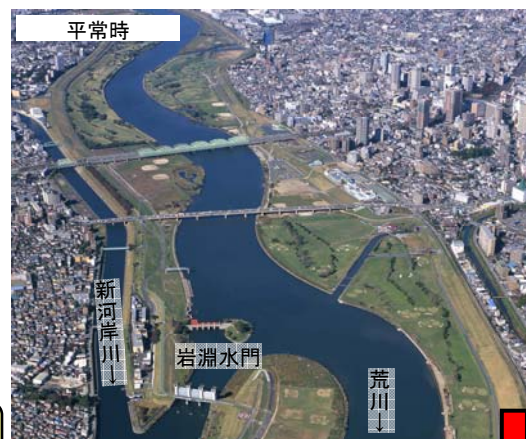
平成11年8月熱帯低気圧 洪水状況
