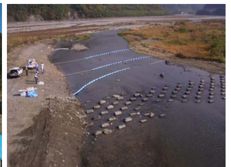
第2部：現地にて、急流河川で有効な誘導展帳方式でのオイルフェンス設置を実施
