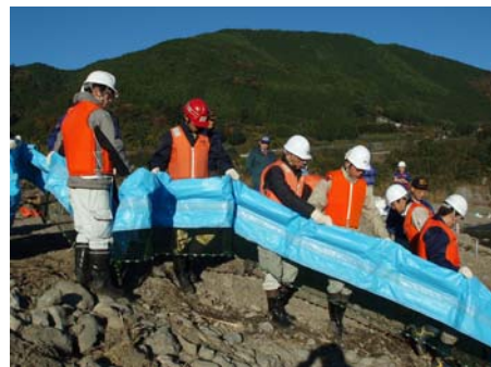
第2部：現地にて、急流河川で有効な誘導展帳方式でのオイルフェンス設置を実施
