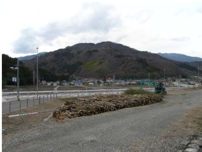
富士川町箱原地先の状況
