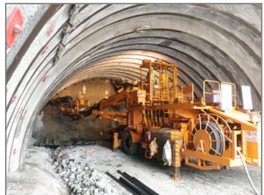
[トンネルの掘削状況]
