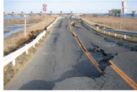
④茨城県神栖市横須（利根川左岸 18.5k 付近）堤防陥没
