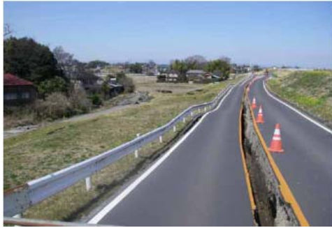
②埼玉県幸手市西関宿（江戸川右岸 57.8k 付近）堤防陥没
