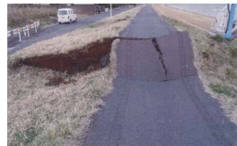
⑫茨城県神栖市息栖（常陸川左岸 11.0k 付近）堤防陥没
