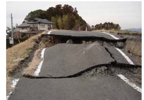
⑬茨城県那珂市本米崎（久慈川右岸 7.0k 付近）堤防陥没
