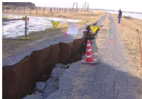
⑩茨城県神栖市日川（常陸川右岸 4.0k 付近）堤防陥没
