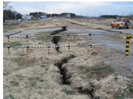
⑦茨城県水戸市下大野（那珂川右岸 4.0k 付近）堤防亀裂
