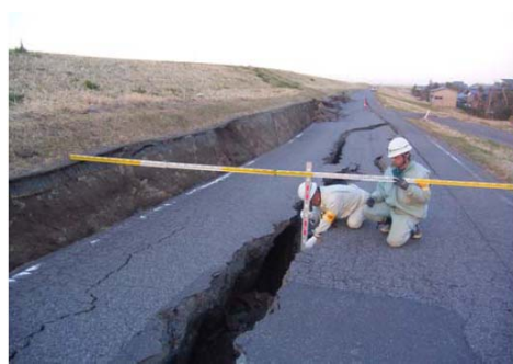
⑥千葉県栄町中谷（利根川右岸 70.0k 付近）堤防陥没
