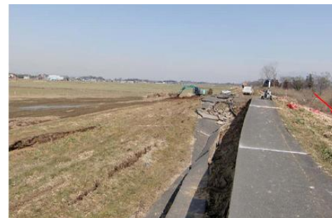
⑪茨城県下妻市鯨（小貝川右岸 39.2k 付近）堤防陥没
