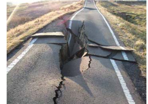
⑨茨城県常陸太田市栗原（久慈川左岸 14.3k 付近）堤防陥没等
