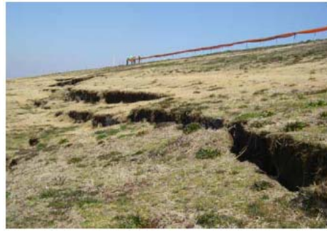
③千葉県野田市関宿（江戸川左岸 58.0k 付近）川表法すべり
