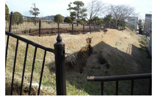
⑤千葉県香取市佐原（利根川右岸 38.8k 付近）堤防陥没等
