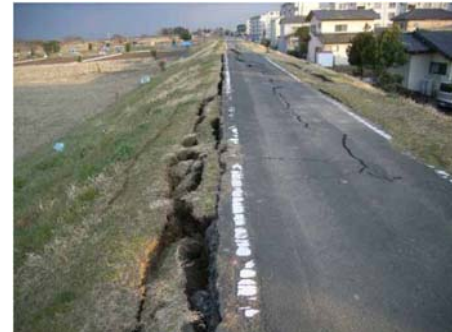
⑧茨城県水戸市若宮（那珂川右岸 9.4k 付近）堤防陥没
