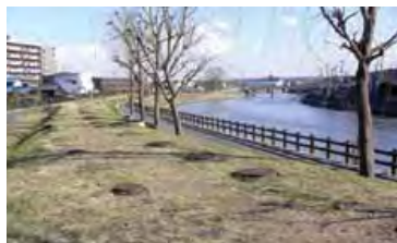
この下に浄化施設があります。
