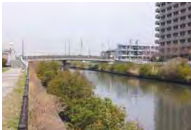
下流から見た桑袋大橋
