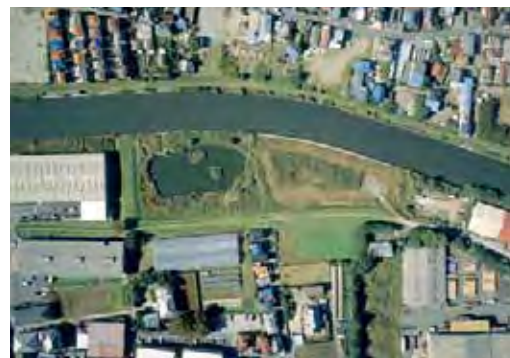
空から見たビオトープ
