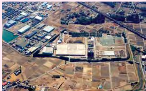
元荒川水循環センター
