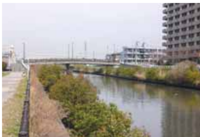
下流から見た桑袋大橋
