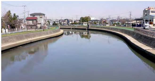
土手はコンクリートで固められています。
