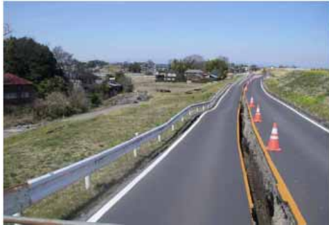
埼玉県幸手市西野宿 (江戸川右岸 57.8k 付近) 堤防備設
