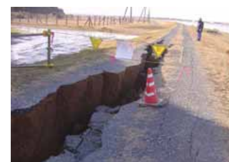
茨城県神栖市日川 (常陸川右岸 4.0k 付近) 堤防備設
