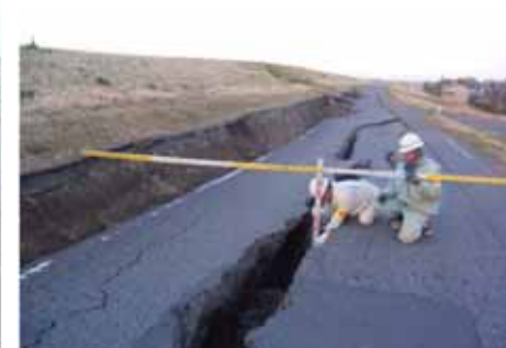
千葉県米町中谷 (利根川右岸 70.0k 付近) 堤防備設
