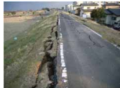
茨城県水戸市若宮 (那珂川右岸 9.4k 付近) 堤防備設
