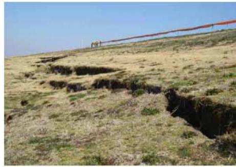
千葉県野田市関宿 (江戸川左岸 58.0k 付近) 川表去すべり
