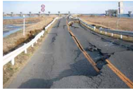
茨城県神栖市横須 (利根川左岸 18.5k 付近) 堤防備設
