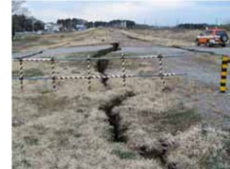
茨城県水戸市下大野 (那珂川右岸 4.0k 付近) 堤防亀裂
