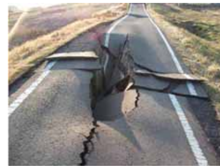
茨城県常陸太田市粟原 (久慈川左岸 14.3k 付近) 堤防備設等
