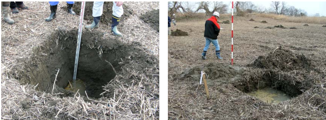
図2-15 上池における試験掘削状況 (H21.02)
