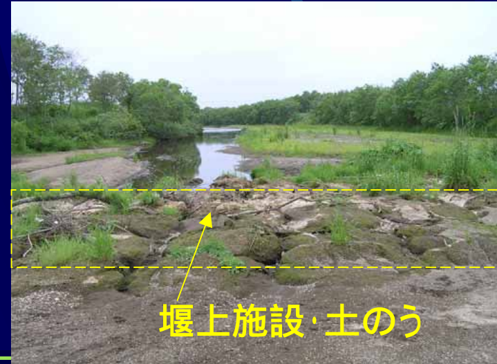
堰上げ施設・下流方向をみる
