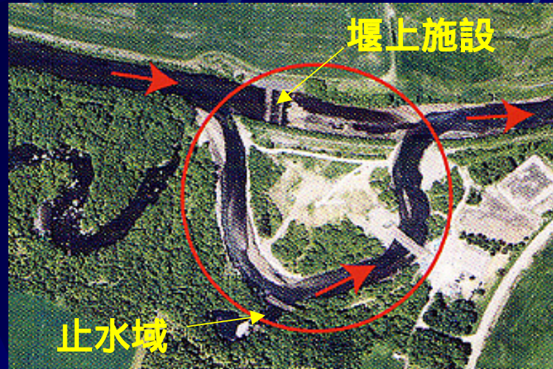
通水後 平成14年
