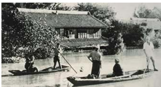
＜昭和 22 年（1947 年）カスリーン台風による洪水の状況＞
