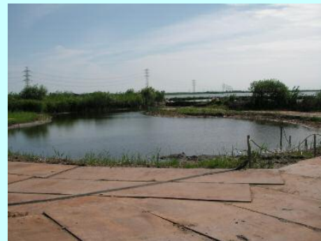
平成 21 年 7 月 14 日 排水停止後、ワンド内は染み出し水により湛水
