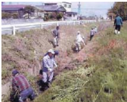
水路の泥上げ
