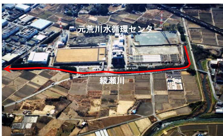
図 3.2.12 元荒川水循環センター（上空写真）
