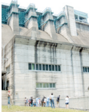
高野ダムは上のほうに4門の発電用ゲートがあるんだ
