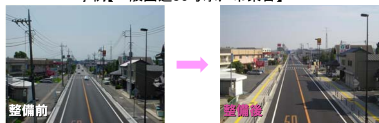
事例【一般国道50号水戸市東台】
