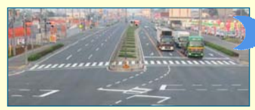
事例【一般国道6号酒門町交差点】
