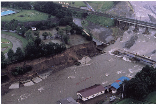
那須町大字寺子乙 （写真：栃木県土木部）
