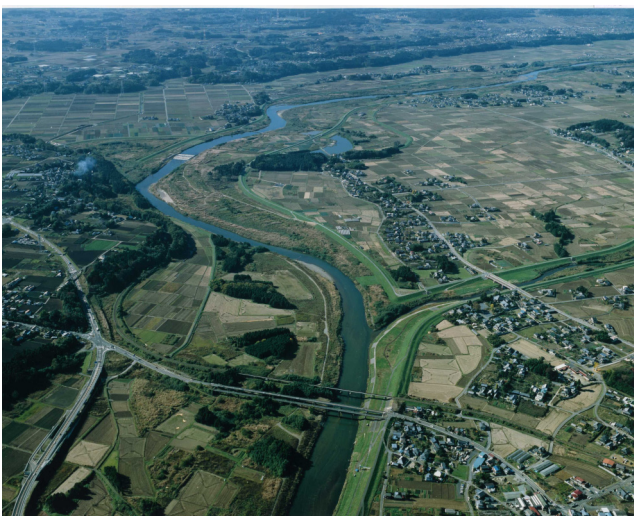
12km 付近 山田川合流点上流（常陸太田市）
