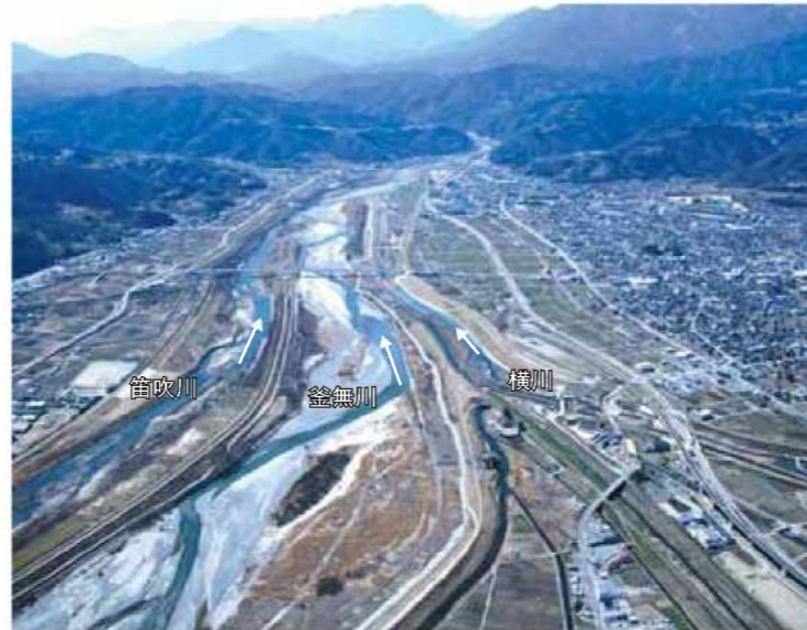
笛吹川・釜無川合流部
