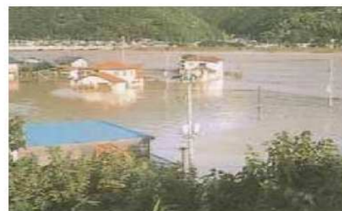
敷沢町の浸水(昭和57年)
