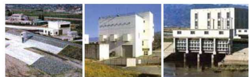
横川排水ポンプ場
