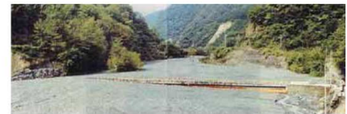
流出土砂により橋梁が埋没(早川)
