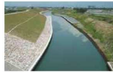
横川拡幅(施工後)
